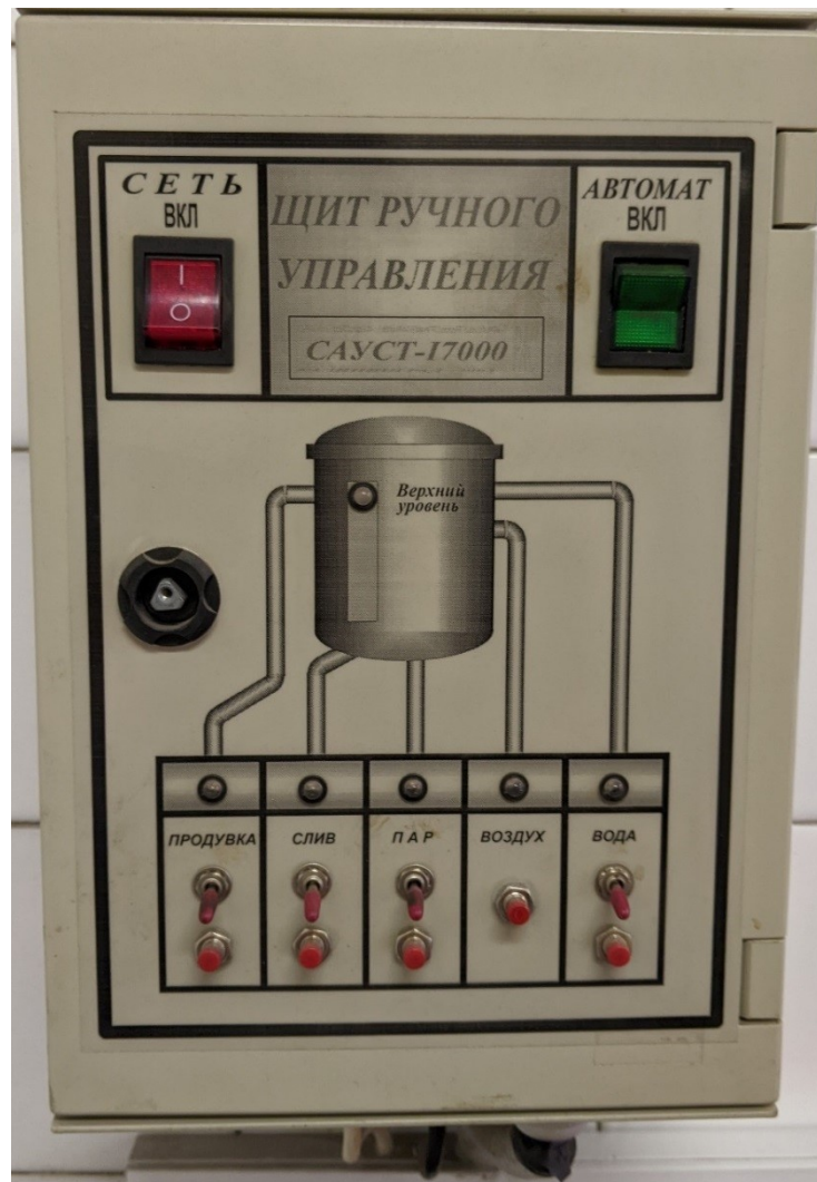
Рисунок 4.15 – Внешний вид лицевой панели щита ручного управления Внутри щита ручного управления размещены:
